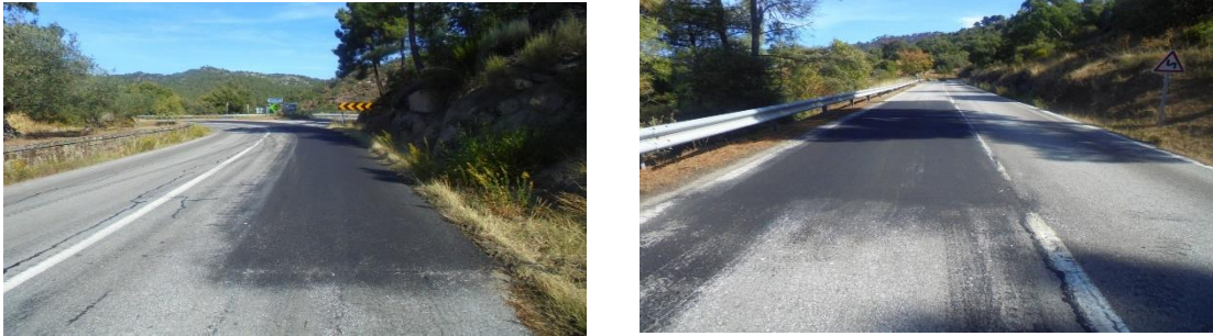
Fig. 4. Fotografias de intervenções de conservação corrente (fresagens pontuais de pavimentos, incluindo o respetivo preenchimento com misturas betuminosas)
