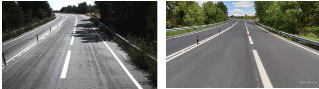
Figura 2- Fotografias de intervenções preventivas nos pavimentos (antes/depois)
