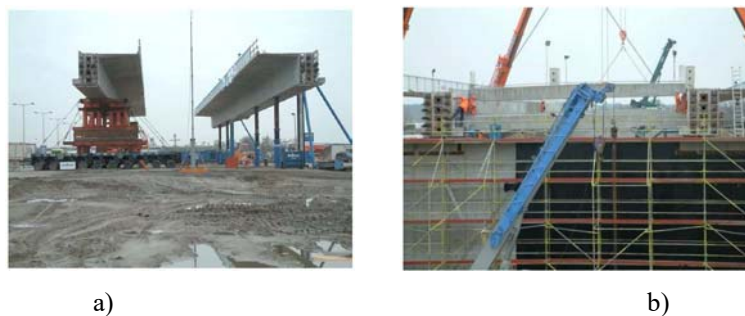
Figura 6 – Viaduto da LAV dos Países Baixos: a) Escoramento provisório das vigas principais; b) montagem das vigas transversais.
