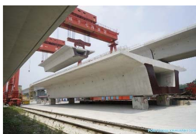
Figura 8 – Viga caixão pré-fabricada pertencente a LAV Zhengzhou-Wanzhou.
