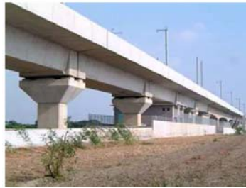
Figura 5 – Vista lateral de um viaduto pertencente à linha C270 da LAV de Taiwan.
