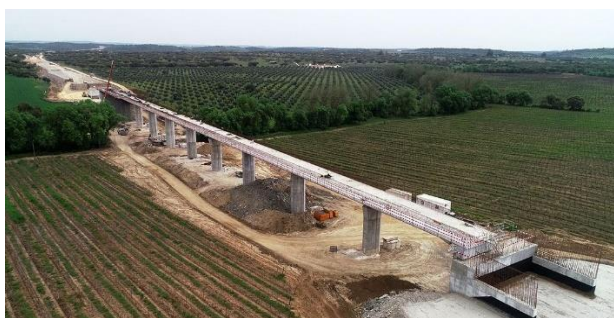
Figura 9 – Linha de Évora, construção do troço Freixo – Alandroal
