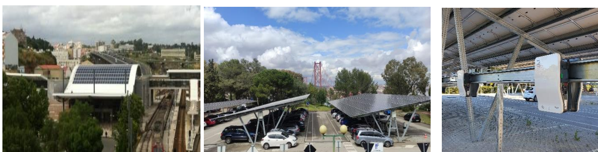
Figuras 6, 7 e 8 – Exemplos de unidades de produção de energia solar nas instalações da IP
