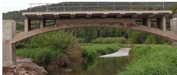
Figura 11. Vista durante a execução do tabuleiro no vão central (fonte: Autores)
