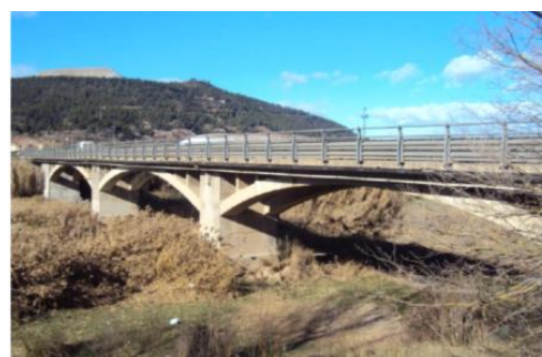
Figura 2. Vista geral da antiga Ponte de Cabrianes (fonte: Autores)
