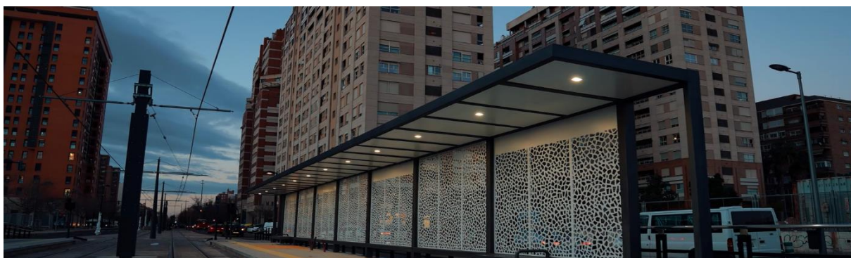
Fig.9. Fotografia do abrigo de uma das paragens terminadas. (Fuente: autora)
