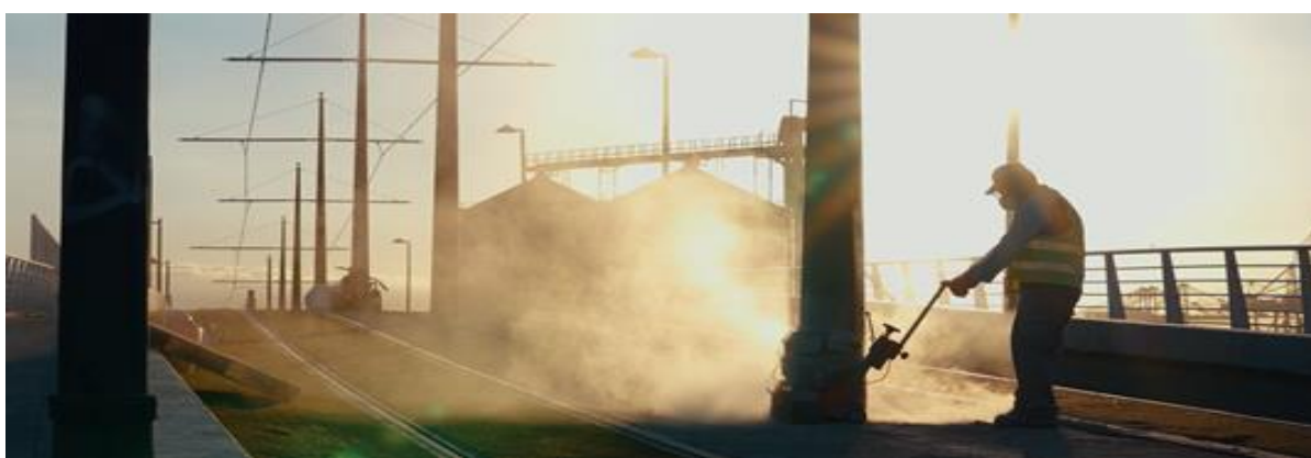
Fig.1. Fotografia de trabalhos na via férrea. (Fuente: autora)
