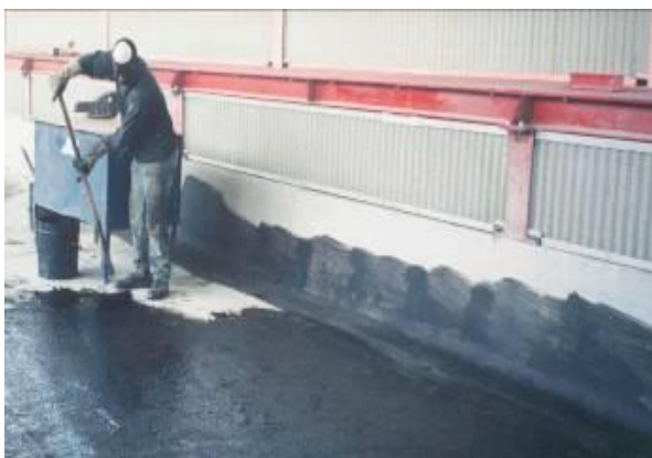
Figura 3 - Aplicação de primário de aderência por rolo e por pistolagem
