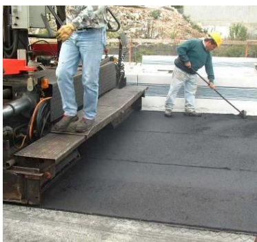
Camada de desgaste (ponte rodoviária)
