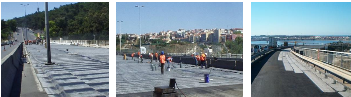
Figura 8 - Vistas parciais do revestimento de impermeabilização
