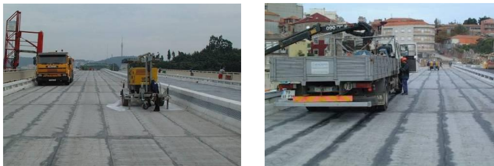
Figura 9 – Circulação controlada de veículos
