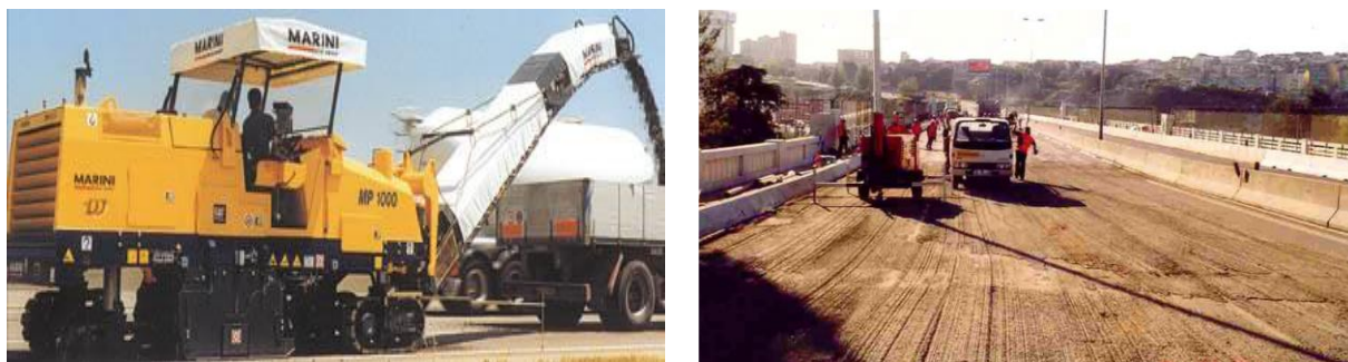
Figura 1 – Trabalhos de fresagem do pavimento existente
