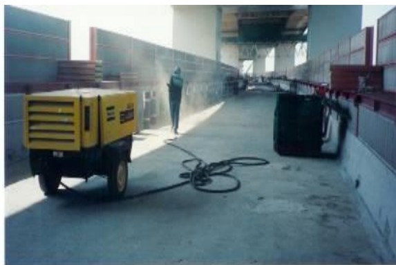
Figura 2 – Trabalhos de limpeza e aspecto visual das superfícies regularizadas
