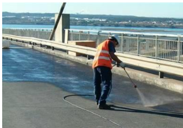
Figura 3 - Aplicação de primário de aderência por rolo e por pistolagem
