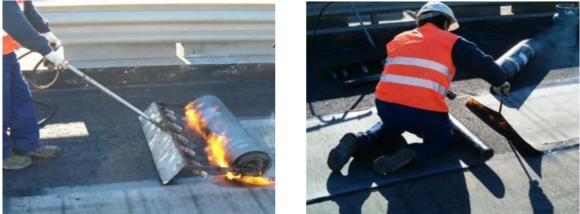
Figura 5 - Soldaduras de sobreposição, de topo e longitudinais
