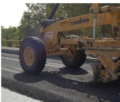
Camada de proteção para aplicação de balastro (ponte ferroviária)
