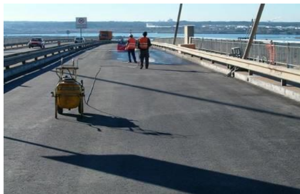
Figura 2 – Trabalhos de limpeza e aspecto visual das superfícies regularizadas
