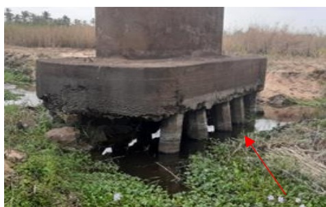
a. Ponte sobre o Rio Licuar (antes)
