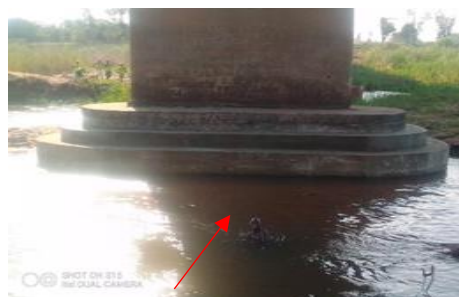
b. Ponte sobre o Rio Licuar (depois)
