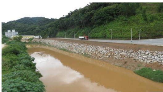
Fig.4. Enrocamento no rio Itajaí-Mirim [11]
