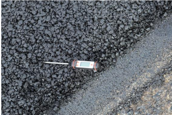
Figura 11 - Aspeto superficial após compactação
