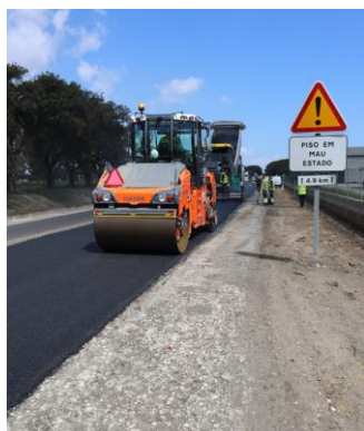
Figura 10 – Espalhamento e compactação
