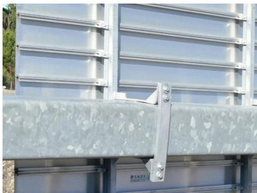
Fig.17. Drone em pórticos - travessa
