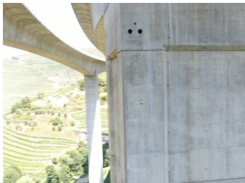
Fig10. Fotografias com drone – pilar
