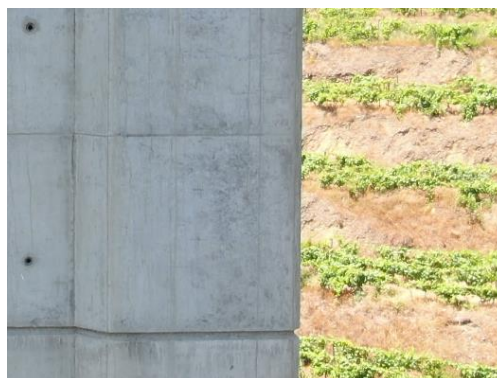
Fig.15. Inspeção a pilares com drone – vista aproximada
