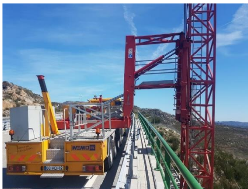
Fig.8. Vista superior da plataforma invertida
