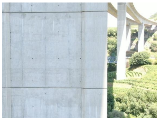
Fig.14. Inspeção a pilares com drone – vista geral
