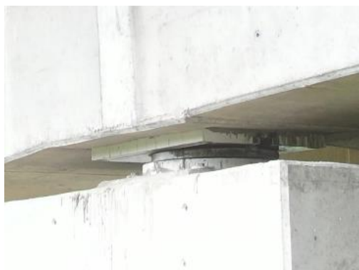
Fig.12. Fotografias com drone – aparelho de apoio
