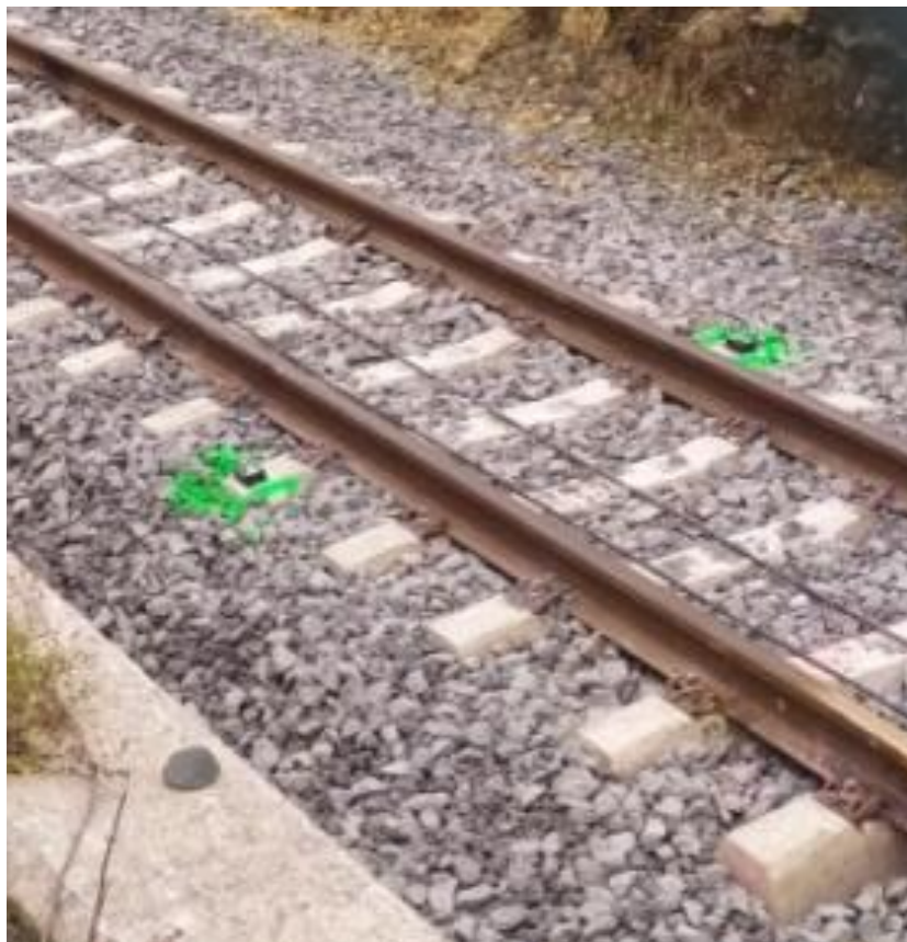
Acclerómetros instalados na secção de teste em Derio (Vizcaya)
